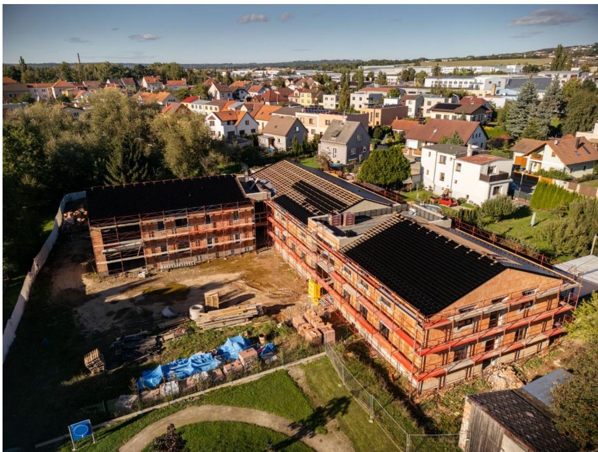
Stavba DZR - září 2025
